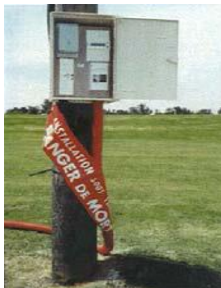
Branchement provisoire sur terrain nu ⇒ non fixe
