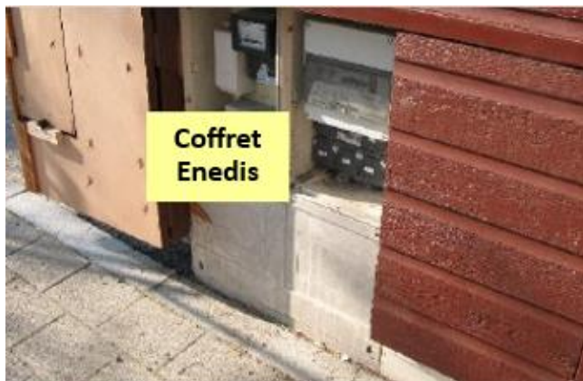
Branchement provisoire sur terrain totalement pré-équipé ⇒ fixe
