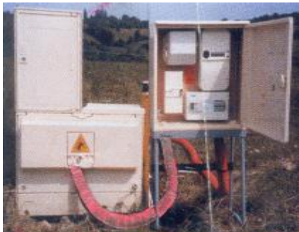
Branchement provisoire sur terrain semi-équipé ⇒ non fixe semi-équipé
